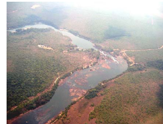
Local proposto para o barramento da UHE Magessi
