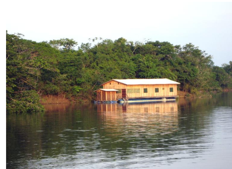
Casa-flutuante para alojamento (locação) para adeptos da pesca esportiva no rio Teles Pires
